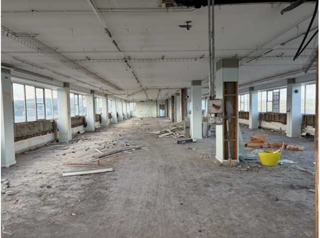
Pencerelerdeki sıva/ahşap kaplamaların kaldırılması
