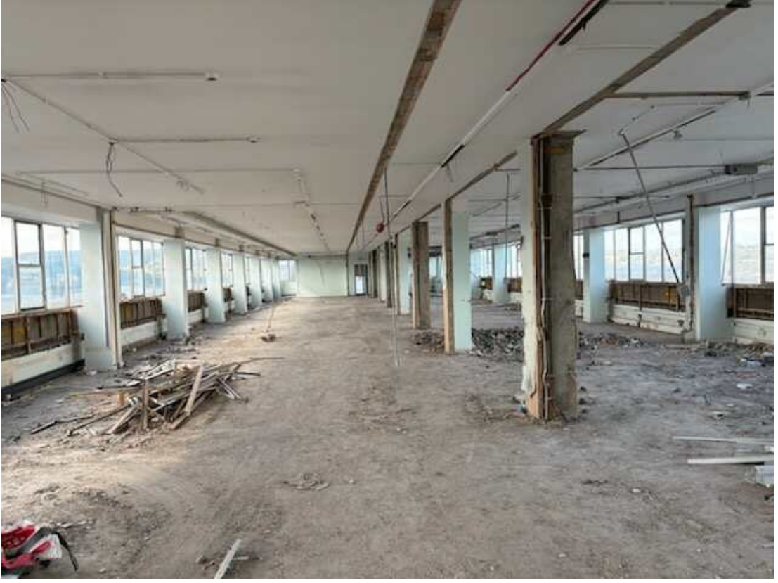
Pencerelerdeki sıva/ahşap kaplamaların sökülmesi
